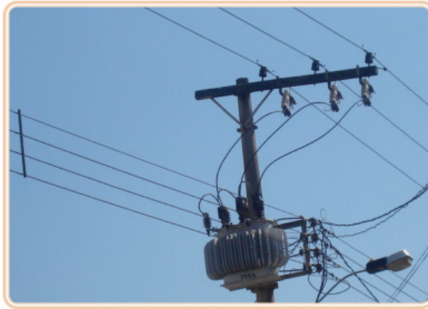
Redes de alta tensão, de baixa tensão e o transformador
