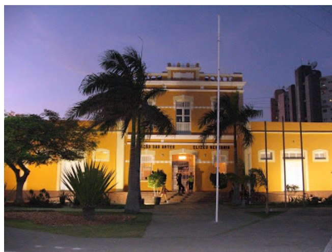
Estação das Artes Elizeu Ventania em Mossoró - RN. Antigo prédio do Sistema Ferroviário Federal, foi recuperado pela Petrobras e hoje abriga a maior parte das festas e eventos sociais da cidade.
