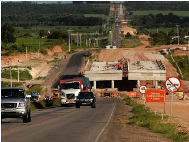
Obras do PAC na BR-101 no município de Goianinha - RN
