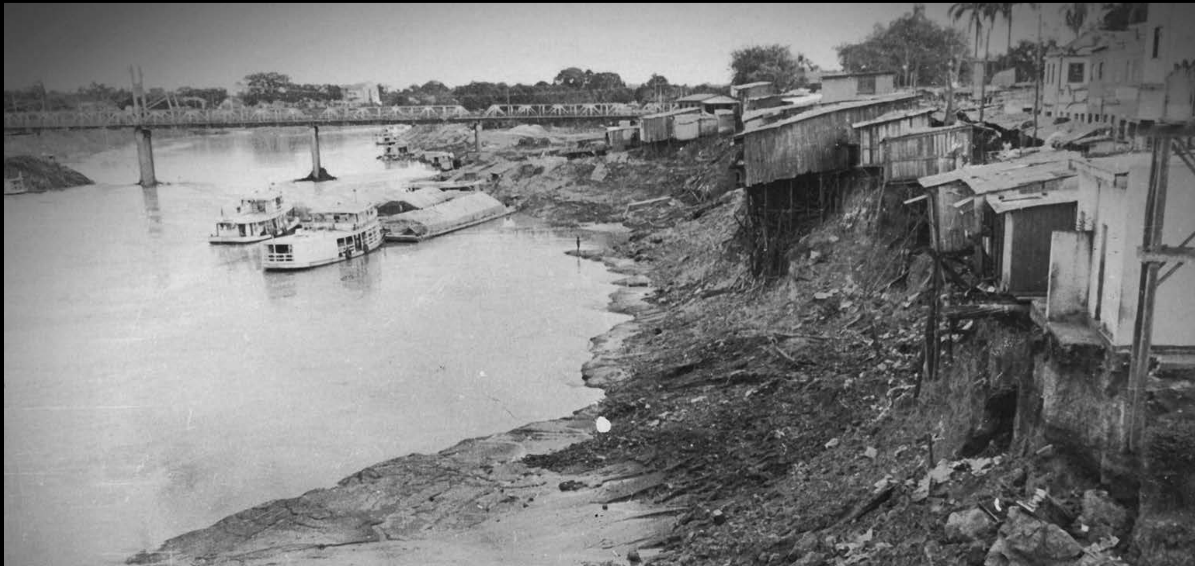
Imagem do descaso. Estruturas que comprometiam a segurança dos frequentadores do antigo Mercado Velho era a realidade de um espaço de história e memórias no centro da capital acreana.
